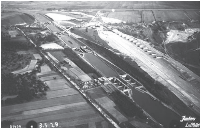
Die vier Schleusenkammern der Schleusentreppe Niederfinow im Jahr 1928
