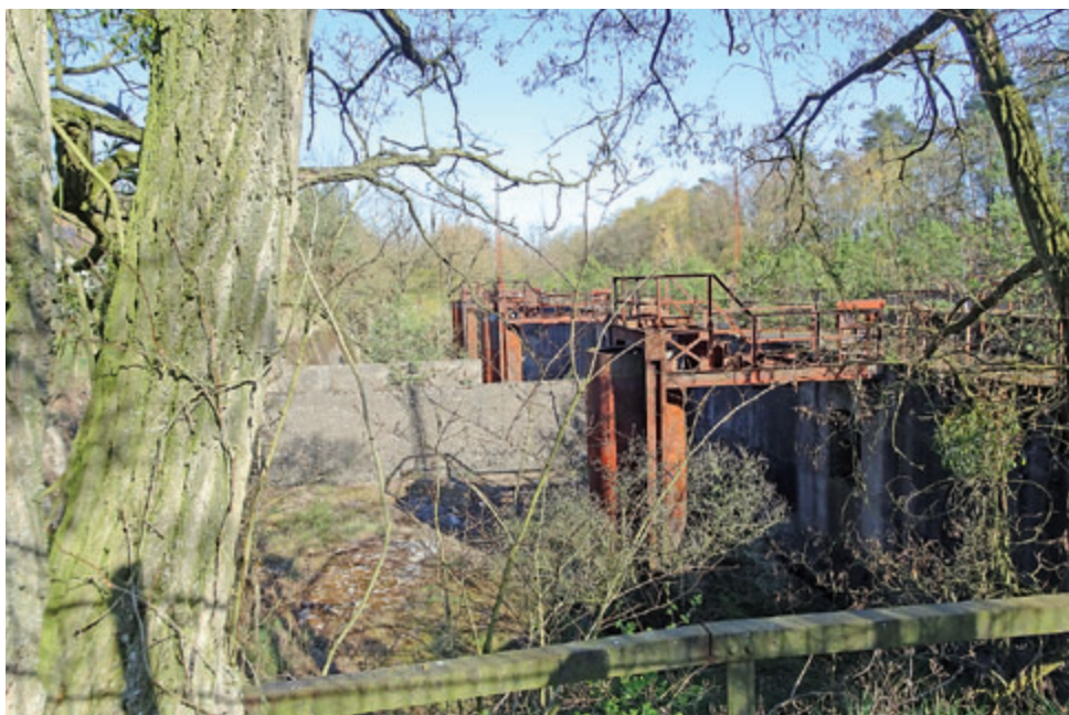
Zuwachsende Schleuse der alten Schleusentreppe
