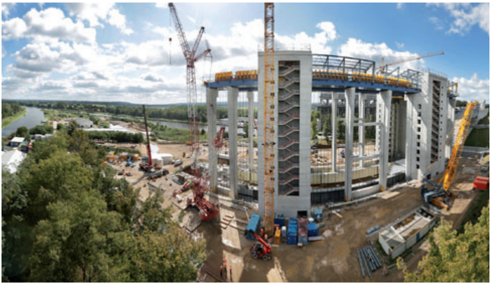
Neues Schiffshebewerk in der Bauphase
