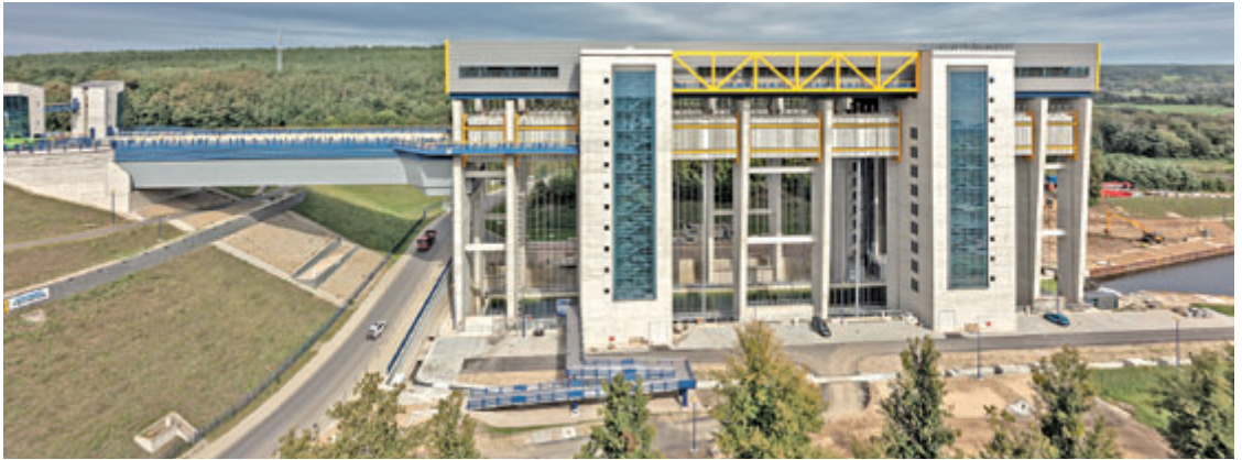
Neues Schiffshebwerk Niederfinow
