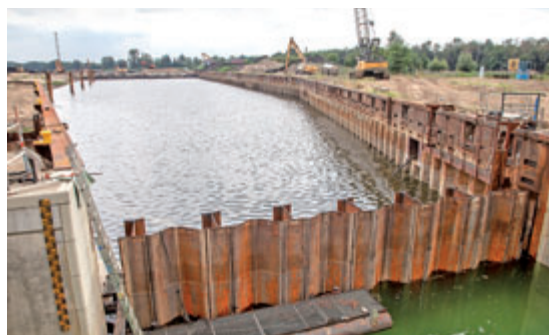
400 Meter lange Umschließung der Baugrube
