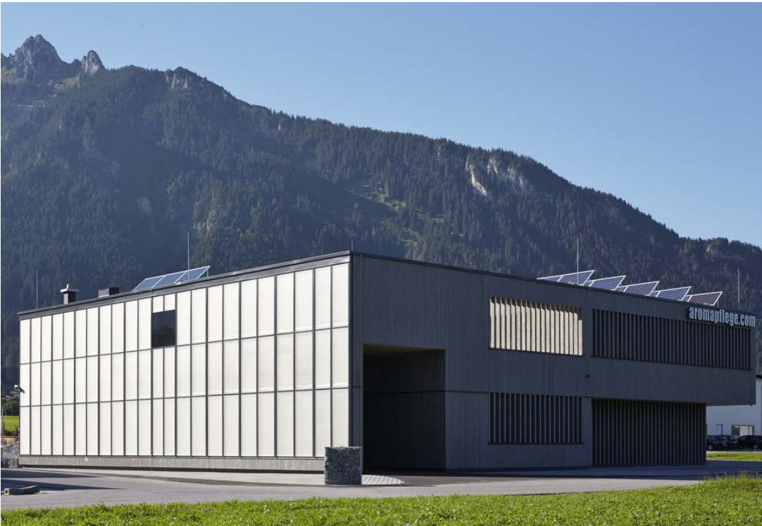
Abb. 9: Gewerbeobjekt in Österreich. Aromacampus Baujahr 2016. In Lechaschau Österreich Bj. 2016 mit 770 m 2 Nutzfläche, Niedrigstenergiestandard Hz rund 28.000 kWh/a, rund 30 kWh/m 2 a, Solarthermiefassade 140 m 2 mit 25 m 3 Langzeitwärmespeicher, Photovoltaik 24 KWp mit 40 kWh Akku Lilo, Restenergiebedarf wird gedeckt mit Rapsöl BHKW, Solare Deckung Wärme ca. 76 %, Solare Deckung Strom ca. 80 %, Bildquelle: Holzbau Saurer Fotograf Müller
