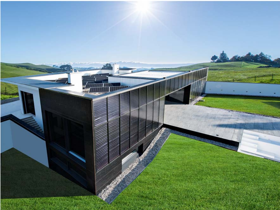
Abb. 5: VitalSonnenhausPro der Firma Bauhütte Leitl-Werke GmbH: Das erste energieautarke Gebäudes Österreichs, Baujahr 2016 in Schwertberg/Österreich. Es ist barrierefrei und hat 141 m 2 Wohnfläche. Wärme, Strom und Mobilität kommen von der Sonne. Zum Einsatz kommen 64 m 2 Solarthermie mit 6 m 3 Langzeitwärmespeicher, 6 kW p Photovoltaik und 19 kWh Akku sowie Pelletkessel mit Stirlingmotor. Bildquelle: Boris Maier/Bauhütte Leitl-Werke
