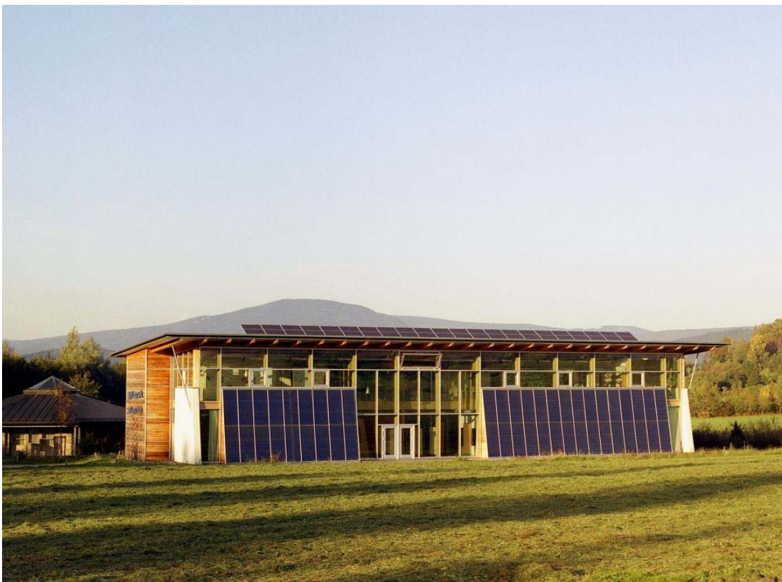
Abb. 7: Besucherzentrum im Bayerischen Wald, Baujahr 2001 mit einer Nutzfläche von 763 m 2 und einem Primärenergiebedarf von 7,5 kWh/m 2 a. Auch dieses gewerblich genutzte Gebäude beheizt sich seit 2001 mittels Solarthermie und Langzeitwärmespeicherung ganzjährig zu 100% nur mit der Sonne. Außerdem erzeugt es noch Solarstrom, hauptsächlich zur Eigennutzung. Es ist über ein kleines Nahwärmenetz mit den Nachbarhäusern verbunden und gibt vom Frühjahr bis Herbst Wärme ab. Quelle: Sonnenhaus Institut e.V.
