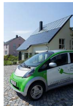
Abb. 4: Intelligente Eigenversorgung mit Wärme, Strom und Mobilität aus der Sonne. Das Haus wird zur Tankstelle. Es hat eine Wohnfläche von 161 m 2 , Solarthermie 46 m 2 mit 9 m 3 Langzeitwärmespeicher, 8,4 KWP Photovoltaik mit 58 kWh Akku. Die ersten beiden bewohnten energieautarken Einfamilienhäuser Europas in Freiberg/Sachsen wurden 2013 errichtet von der HELMA Eigenheimbau AG. Drei Jahre lang wurden diese beiden Häuser durch die TU Bergakademie Freiberg messtechnisch untersucht. Primärenergiebedarf: 7 kWh/m 2 a, Stromverbrauch 2.100 kWh/a, Holzbedarf 2-3 rm/a. Solare Deckung Strom 98 %, Wärme 70 %, E Mobilität 85 %.
