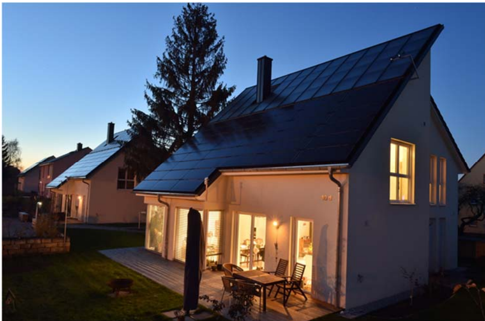
Abb. 4: Intelligente Eigenversorgung mit Wärme, Strom und Mobilität aus der Sonne. Das Haus wird zur Tankstelle. Es hat eine Wohnfläche von 161 m 2 , Solarthermie 46 m 2 mit 9 m 3 Langzeitwärmespeicher, 8,4 KWP Photovoltaik mit 58 kWh Akku. Die ersten beiden bewohnten energieautarken Einfamilienhäuser Europas in Freiberg/Sachsen wurden 2013 errichtet von der HELMA Eigenheimbau AG. Drei Jahre lang wurden diese beiden Häuser durch die TU Bergakademie Freiberg messtechnisch untersucht. Primärenergiebedarf: 7 kWh/m 2 a, Stromverbrauch 2.100 kWh/a, Holzbedarf 2-3 rm/a. Solare Deckung Strom 98 %, Wärme 70 %, E Mobilität 85 %.
